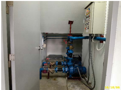
ถังสำรองน้ำใช้ และเครื่องสูบน้ำขึ้นใต้ดิน
